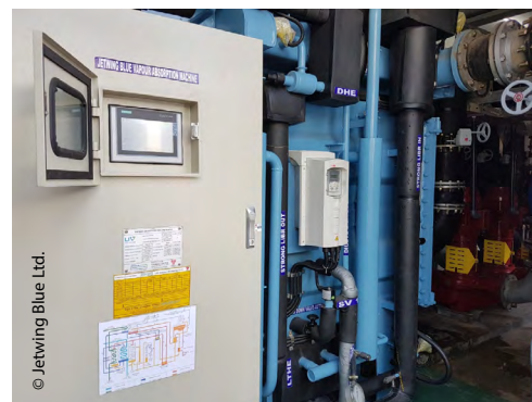
Le système de réfrigération à absorption de vapeur au Jetwing Blue
