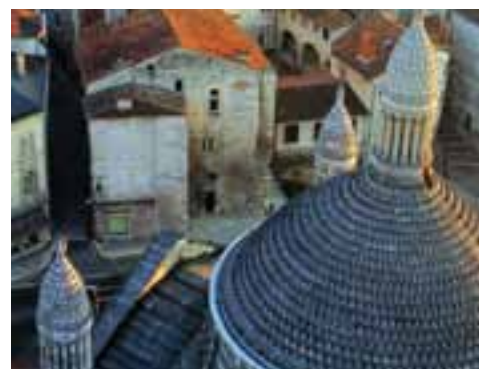
Saint-Front Cathedral (Périgueux). © OT de Périgueux
