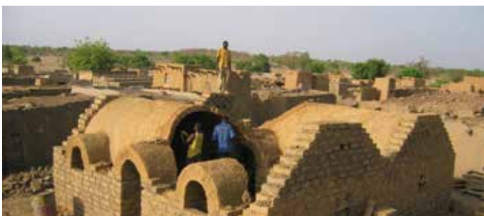
© La Voûte Nubienne
