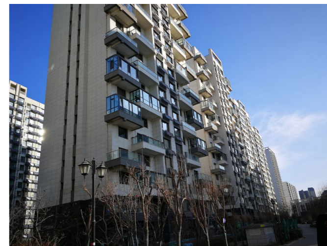
在水一方二期住宅楼外部实景
