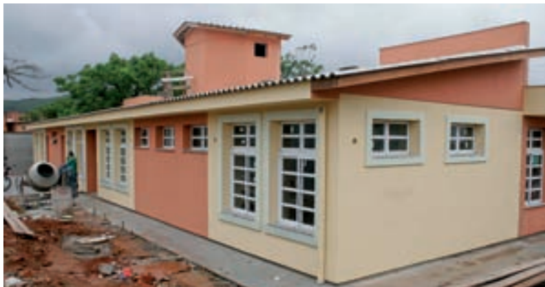
Obras na Escola Municipal Paulino Azurena em Porto Alegre.
