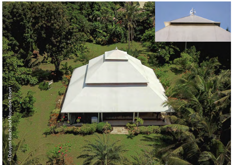
Les nouveaux pulvérisateurs d'eau posés sur le toit de la tente
