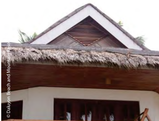
Persiennes de ventilation installées sur le toit de l'une des chambres de l'hôtel
